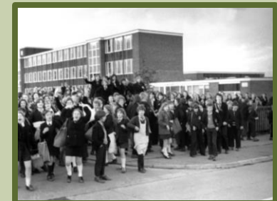
1974, awon ọmọ ile-iwe Kenton School njade nínú iṣotẹ lóri aṣo ile-iwe.
