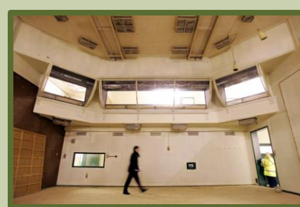
Intérieur du bunker Kenton lors d'une inspection en 2008.
