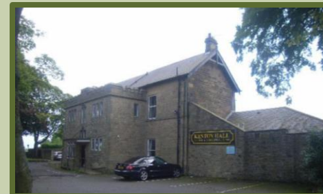
Kenton Hall avant sa démolition en 2009.
