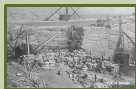
Carrière de Kenton – ouvriers taillant la pierre avec de vieux outils.
