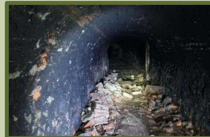
现在无法进入的Kitty's Drift地下轨道内部。
