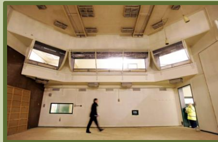
2008年Kenton掩体内部检查。
