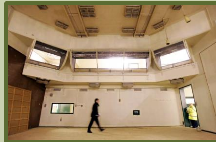
Innenansicht Kenton Bunker bei einer Inspektion 2008.
