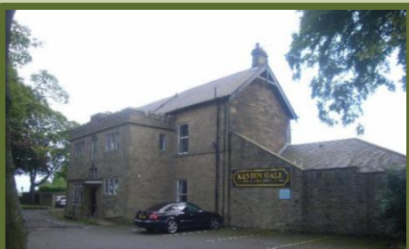
Kenton Hall vor dem Abriss 2009.
