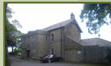
Kenton Hall przed rozbiórką w 2009.
