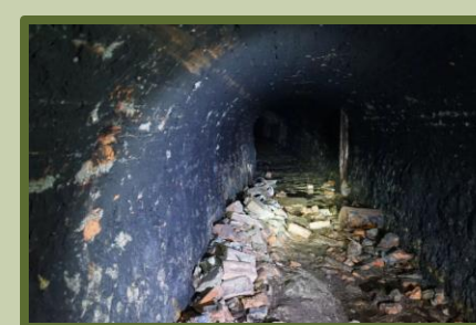
Wnętrze nieprzystępne j teraz podziemnej trasy Kitty's Drift.
