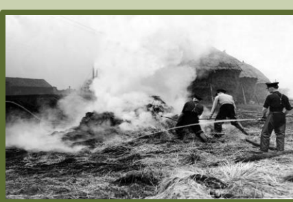
Strażacy gaszą pożar stosu w Manor House Farm, Kenton, Newcastle.
