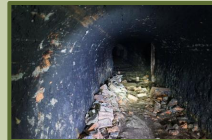
Interior de la vía subterránea Kitty's Drift, ahora inaccesible.
